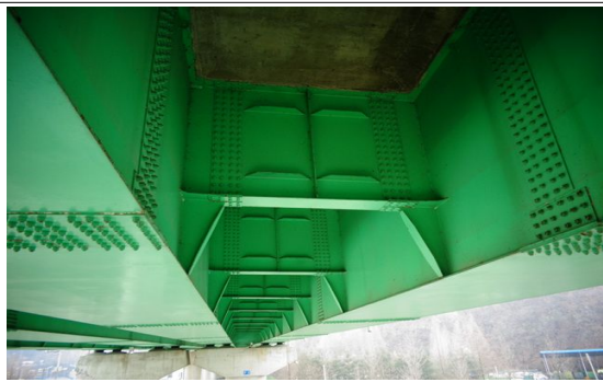
바닥판하면 및 거더 외부 전경
