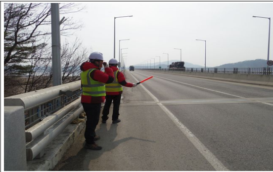
도보를 이용한 외관조사
