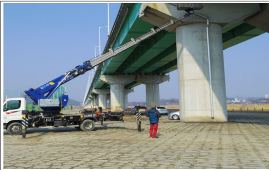
고소차를 이용한 외관조사
